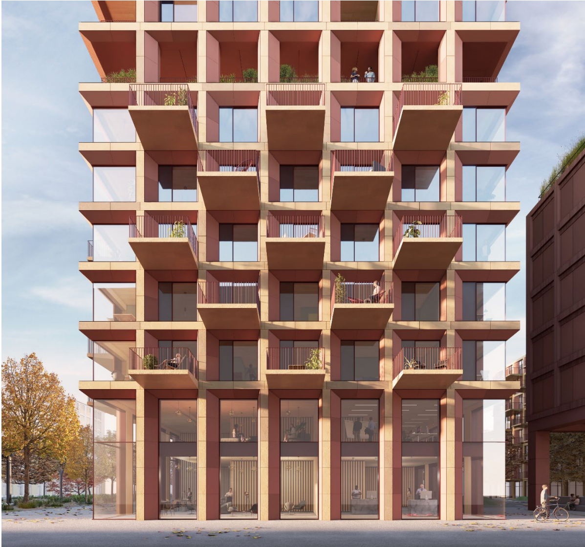
Die innovative Holzkonstruktion, die von Implenia zusammen mit der ETH Zürich und WaltGalmarini eigens für Hochhäuser entwickelt wurde, wird mit Fassaden aus Terracotta umhüllt. (Bild: Ina Invest)
