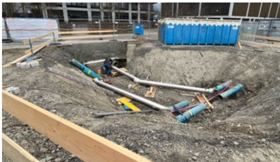
Zu den Tiefbauarbeiten gehörte die Umlegung von Leitungen zum Rückkühlwerk. Durch diese Anlage kann über die Nutzung der Luftaustemperatur das Anergienetz gezielt erwärmt oder gekühlt werden.
