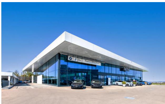
Wil (SG), Flawilerstrasse 23
