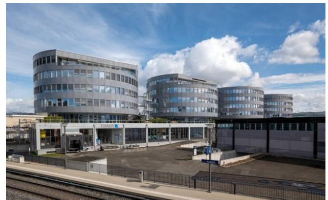
Steinhausen (ZG), Turmstrasse 28/30
