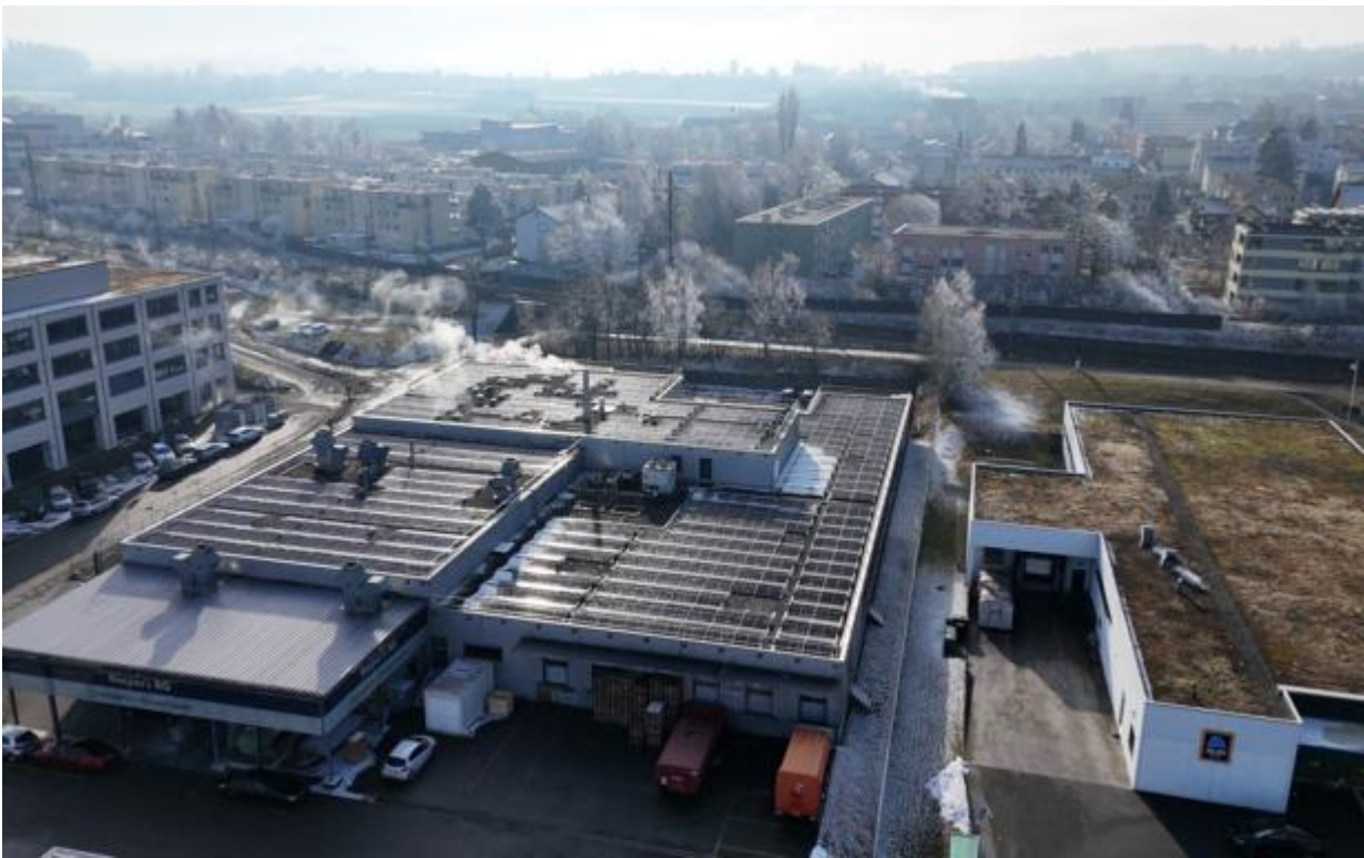
Solar Power System Rümlang (ZH), Hofwiesenstrasse 48
