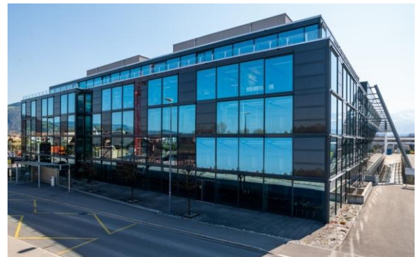
Gwatt (Thun), Schorenstrasse 39
