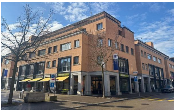
Romanshorn (TG), Bahnhofstrasse 16, Alleestrasse 25
