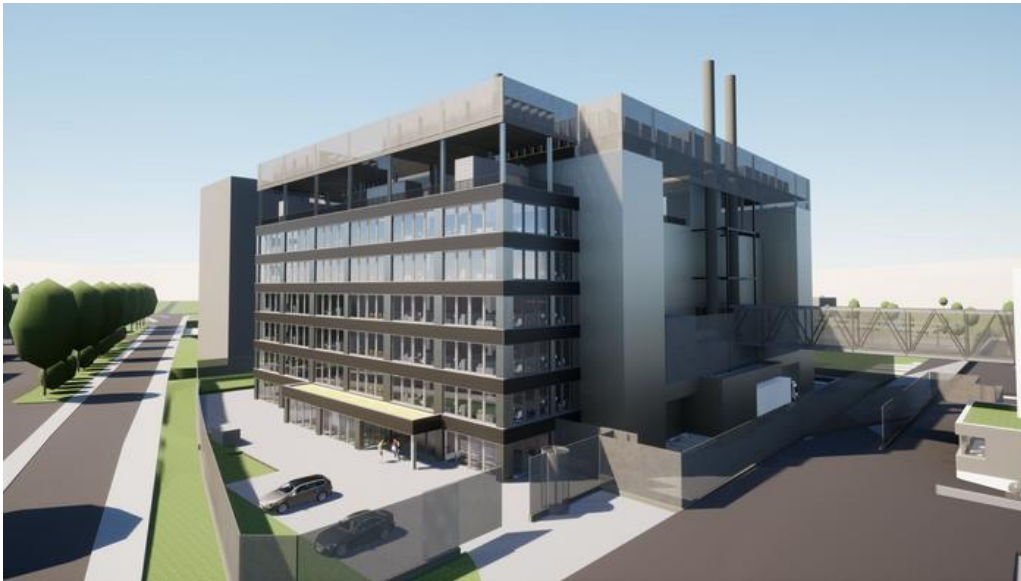
Das neue Datacenter auf dem Green-Metro-Campus Zürich West (Bild: ©zVg).
